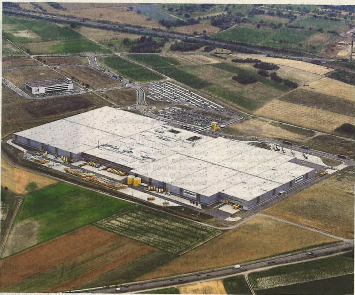
Der Flächenverbrauch beschäftigte gestern den Planungsausschuss des Regionalverbands in Mühlacker. Dabei wurde auch das Amazon-Logistikzentrum in Pforzheim angesprochen. Das Luftbild entstand im August dieses Jahres.
