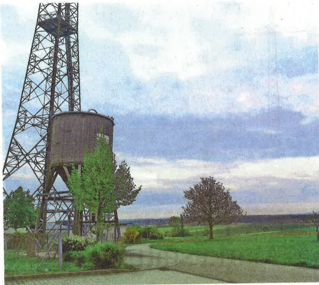
Rechts vom RWE-Sendemast und vom Salzsilo des Bauhofes am südlichen Ortsrand von Göbrichen soll das interkommunale Gewerbegebiet entstehen. FOTO: MARTIN SCHOTT
