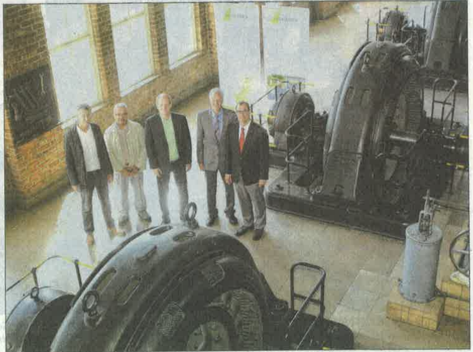
SEIT 93 JAHREN ist dieses Wasserkraftwerk zwischen Mühlhausen und Roßwag in Betrieb. Auf dem Bild: (von links) Rolf Schönhaar (EnBW), Helmut Andrä, Dirk Büscher und Jürgen Kurz (alle Regionalverband) sowie Mühlackers OB Frank Schneider. Foto: Kollros
