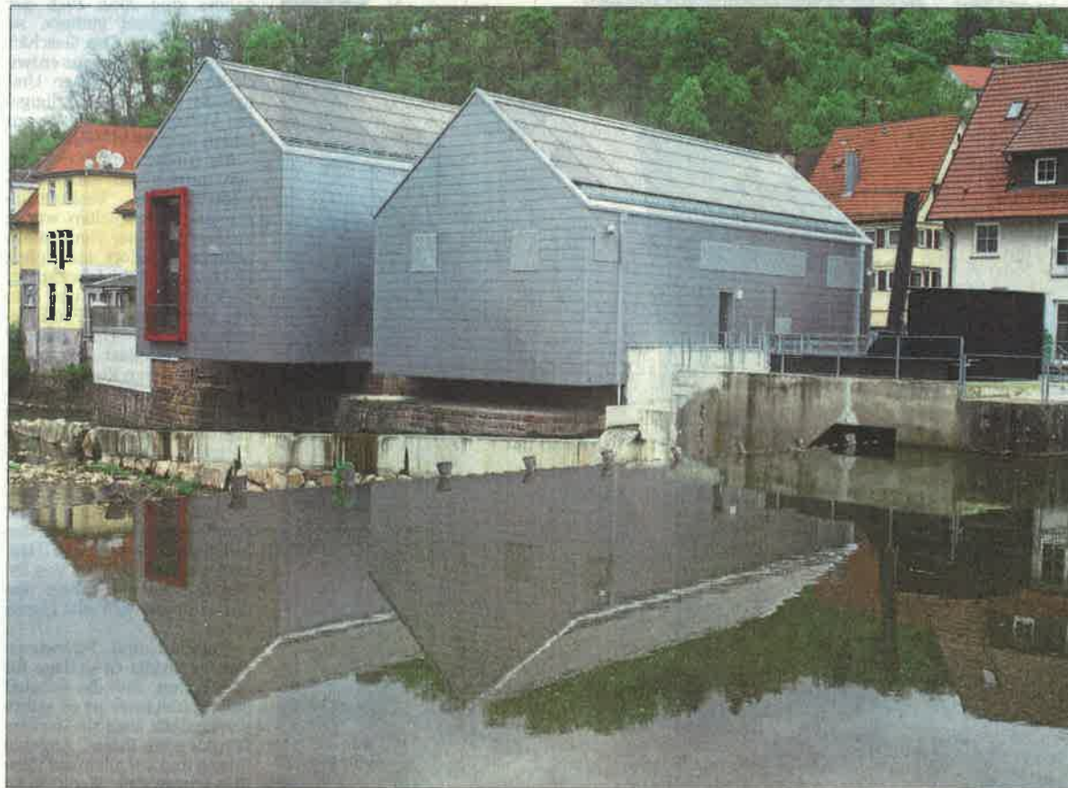
Das im Frühjahr 2014 in Betrieb gegangene Wasserwerk der Energie Calw GmbH kann am kommenden Sonntag beim Nordschwarzwaldtag besichtigt werden. Foto: Hölle
