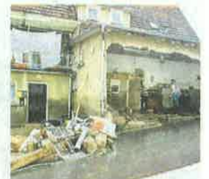
Eine schlammige Wasserwalze spülte am 19. Juli 1999 in Unterrelchenbach ganze Mauern weg.
