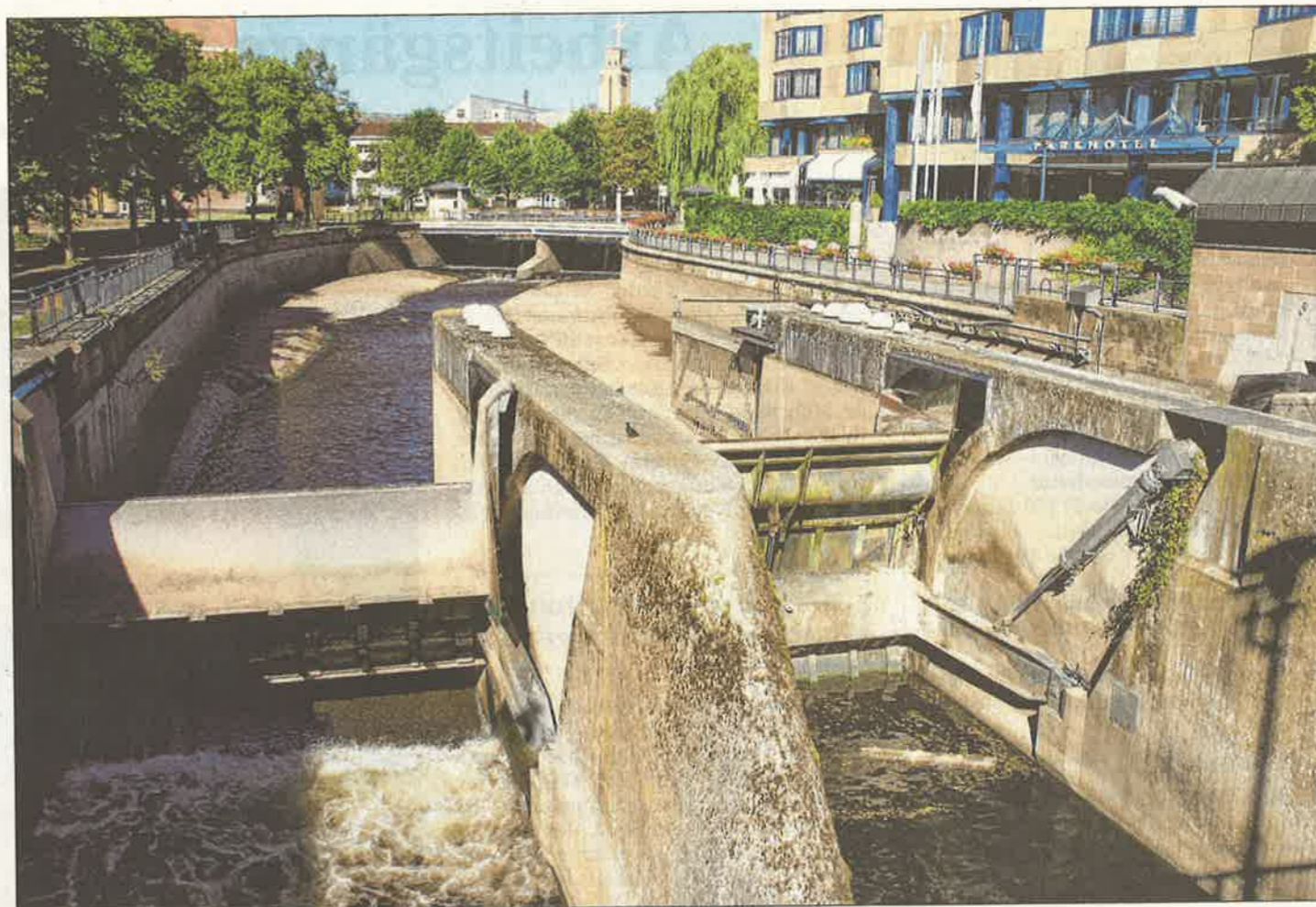
DAS FLUSSKRAFTWERK AUERBRÜCKE gehört zu den Pforzheimer Angeboten bei den EnergieErlebnisTagen, an denen sich im Nordschwarzwald 20 Kommunen und Einrichtungen beteiligen. Foto: Stadtwerke
